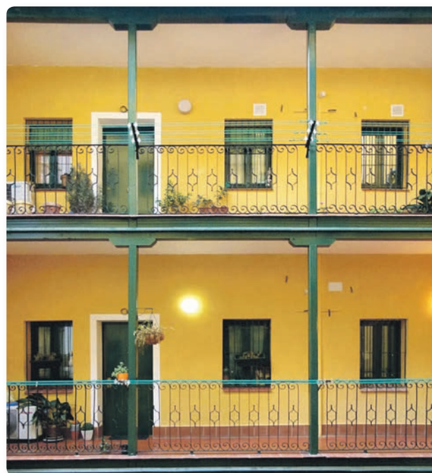
▲ Viviendas sociales de la calle San Cayetano, 10 Panorámica de las fincas de los números 8 y 10 ▼
