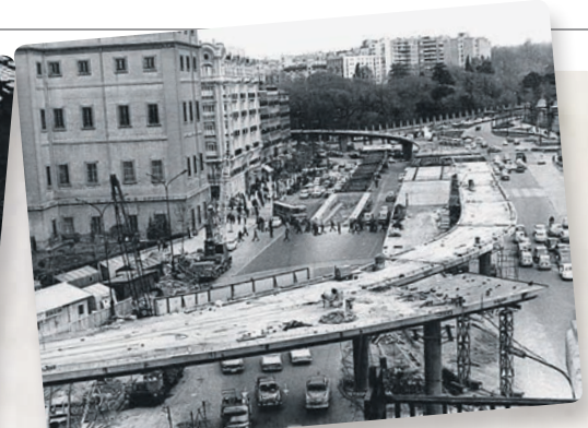
📷 La construcción del paso elevado de Atocha, 1968 ▲
