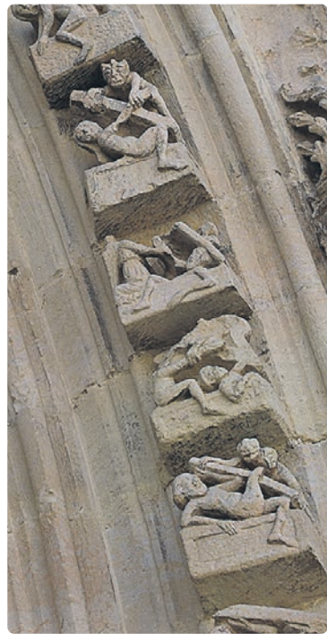
Juicio Final: Detalle del pórtico norte de la iglesia de Santa María la Real de Nieve (Segovia)
