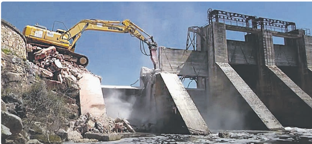
Demolición en 2018 de la presa de Yecla de Yeltes en el río Huebra (Salamanca)
